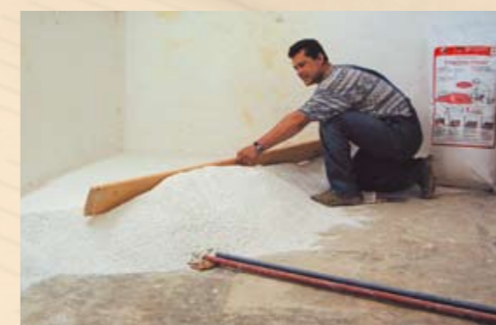
Zasypki perlitowe świetnie sprawdzają się w rozwiązaniach podłóg do ociepleń i wygłuszeń akustycznych.
