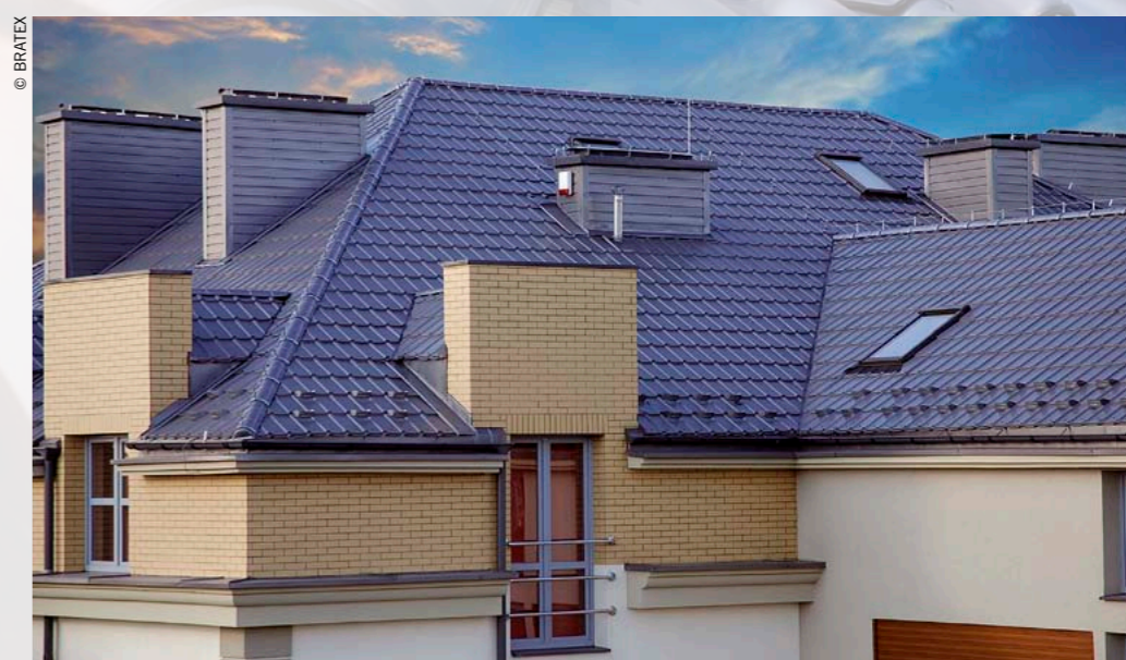
powyżej: Blachodachówka: profile wytłoczek zwykle inspirowane są dachówkami ceramicznymi.
