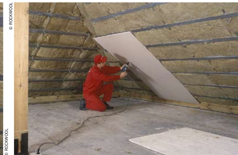
Montaż płyt gipsowo-kartonowych
