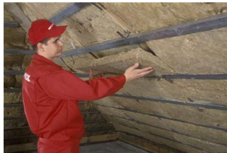
Układanie drugiej warstwy izolacji
