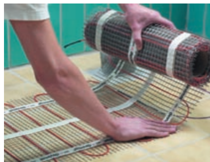
kolejność układania mat grzejnych elektrycznego ogrzewania podłogowego
