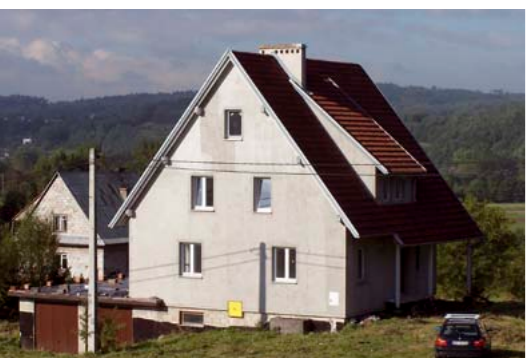
Fot. 2 Otynkowana elewacja budynku (prawdopodobnie jest to tynk maszynowy naniesiony na ścianę wykonaną z bloczków komórkowych, po utwardzeniu można go pokryć farbą elewacyjną)
