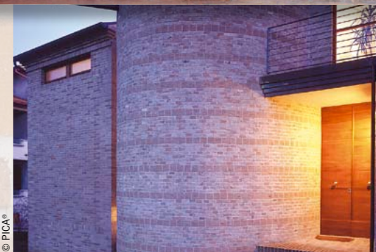
Fot. 4 Wygląd elewacji z cegły ceramicznej
