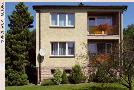
Fot. 5 Wygląd elewacji skomponowanej z tynków szlachetnych: strefę cokołową tworzy tynk boniowany imitujący regularne płyty kamienne, ponad nią nałożono tynk szlachetny nakrapiany (tzw. baranek)
