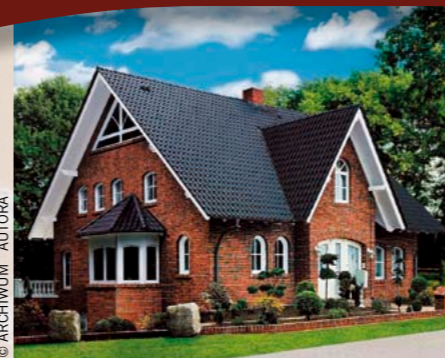
Fot. 3 Wygląd elewacji z cegły klinkierowej
