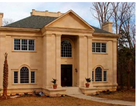
Fot. 1 Zaprawa Limestone imitująca na elewacji wygląd naturalnego piaskowca
