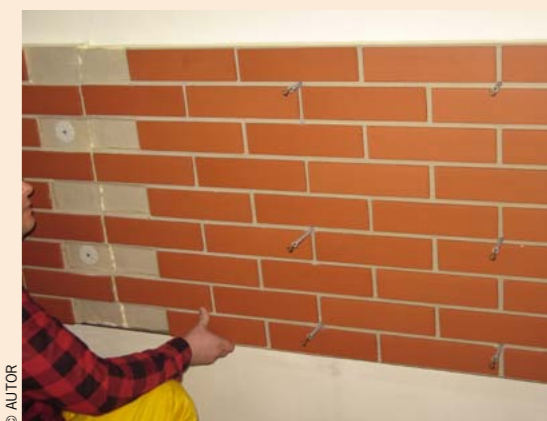
Fot. 4: Faza mocowania do ściany modułowej warstwy ociepleniowej (szytwny PUR + płytka klinkierowa) do ściany konstrukcyjnej, która wraz z dociepleniem kwalifikowana jest jako ściana dwuwarstwowa (system Mathermic®)
