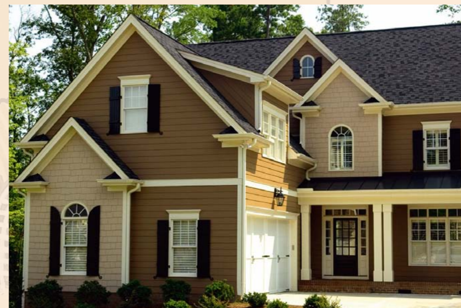
Fot. 3: Przykład realizacji budynku ze elewacyjnymi ścianami dwuwarstwowymi. Warstwę zewnętrzną (ocieplającą) stanowi siding włóknocementowy.
