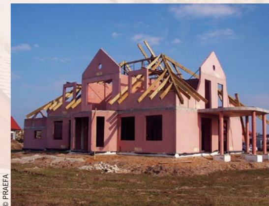
powyżej: montaż domów z prefabrykowanych elementów
