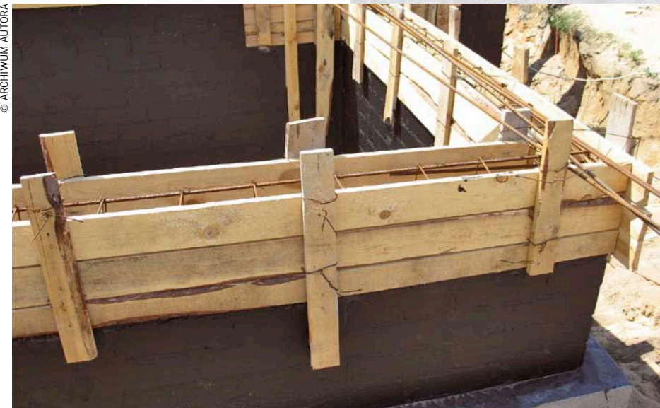
Fot. 5 Faza wykonywania ścian piwnicznych usytuowanych na ławie fundamentowej. Wylewanie płyty cokołowej, na której spoczną ściany nośne. Na zdjęciu widoczne jest także wstępne zabezpieczenie ściany masą asfaltową zapobiegającą penetracji wody gruntowej w struktury muru.
