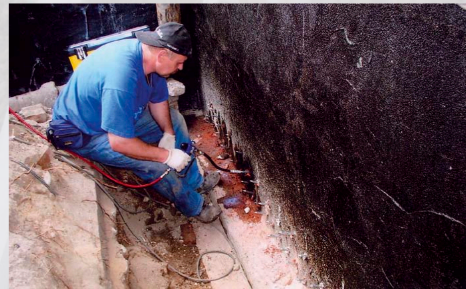
Fot. 7 Osuszanie ściany fundamentowej metodą iniekcyjną. W murze nawierca się szereg otworów, w których montowane są pakery podające ciśnieniowo odpowiednie substancje iniekcyjne.
