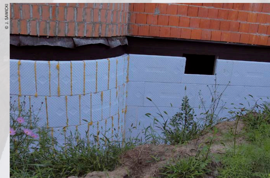
Fot. 4 Ocieplanie ściany fundamentowej płytami XPS (styropian ekstrudowany). Miejsca połączeń dla wyeliminowania mostków termicznych oraz infiltracji wody i wilgoci wypełnione są pianką poliuretanową.
