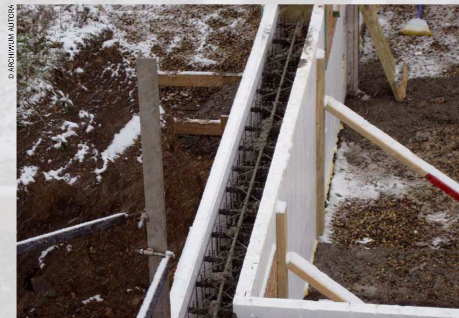
Fot. 3 Przygotowanie ławy fundamentowej pod wylewkę, która jest docieplana w metodzie „traconego” szalunku termoizolacyjnego
