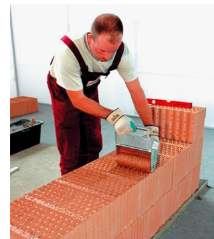
nanoszenie zaprawy za pomocą wałka
