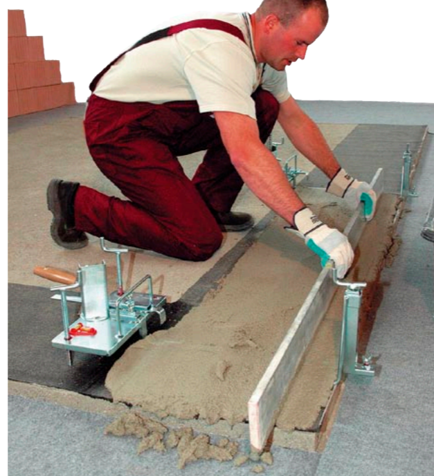
wyrównywanie podłoża pod pierwszą warstwę cegieł
