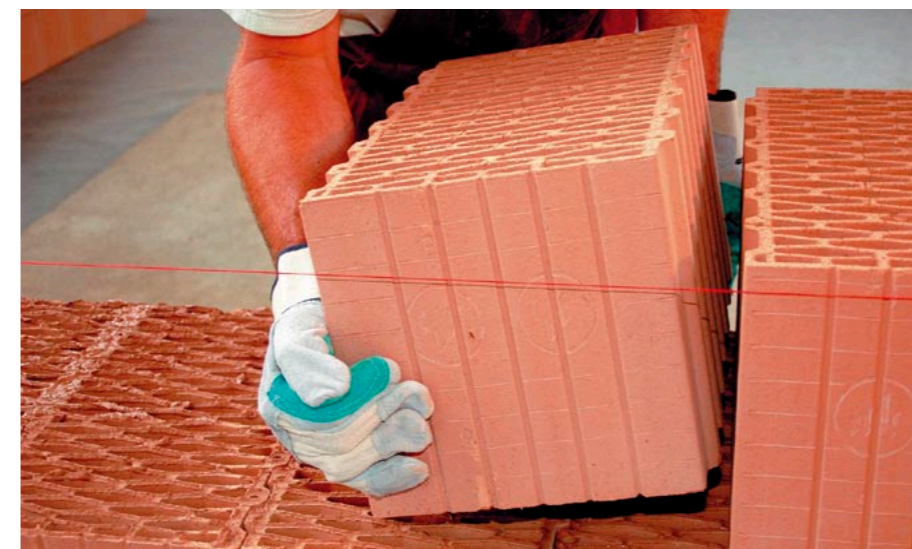
układanie kolejnych warstw pustaków Porotherm Profi
