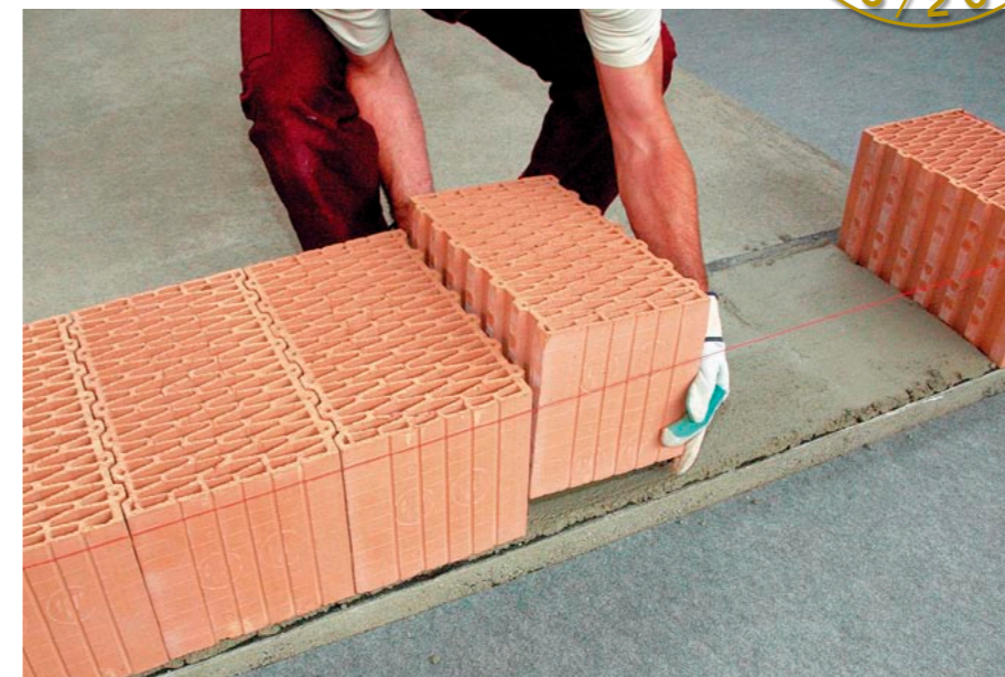
układanie pierwszej warstwy cegieł
