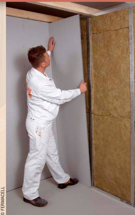
fot. 5 (po lewej): Końcowy etap montażu szkieletowej ścianki działowej: mocowanie do rusztu płyty włóknogipsowej. Wypełnienie rusztu stanowi widoczna wełna mineralna
