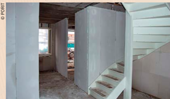
fot. 3: Przykład wykorzystania wielkoformatowych płyt z betonu komórkowego do szybkiego montażu ścian działowych
