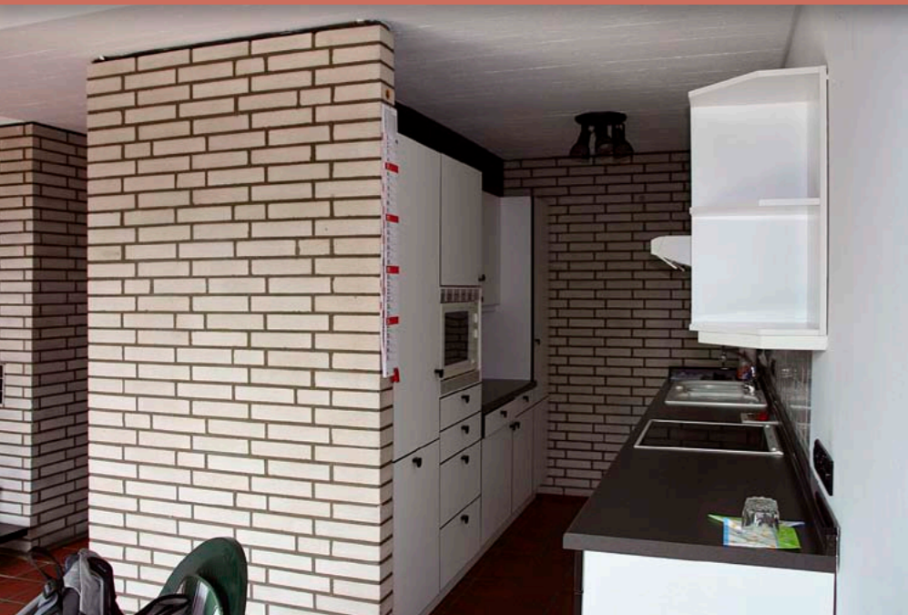
fot. 1: Przykład wykorzystania cegły wapienno-piaskowej (silikatowej) w konstrukcjach ścian: działowej (na pierwszym planie) i nośnej (w głębi)
