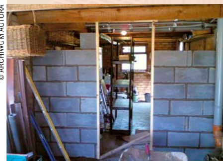
fot. 2: W budowie ścian działowych sprawdzają się technologie wykorzystujące bloczki z betonu komórkowego
