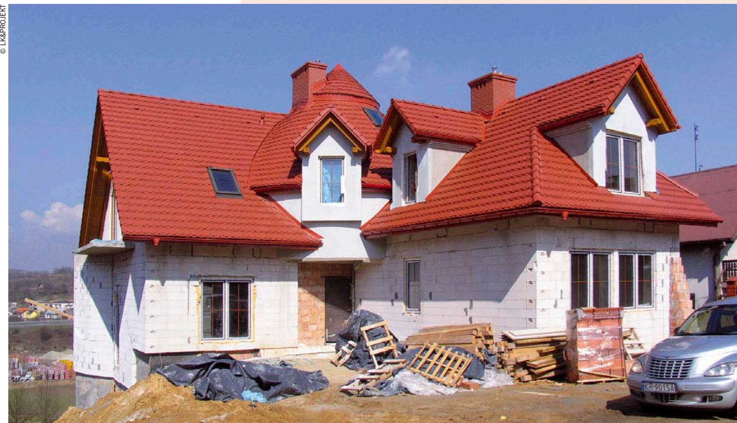
Dom PDJ-1870 (LK&34) w trakcie budowy
